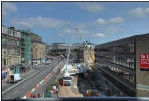
Haymarket Viaduct Concrete Pour
