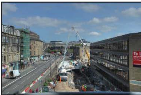
Haymarket Viaduct Concrete Pour
