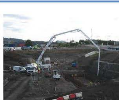
Edinburgh Gateway Attenuation Tank Base Pour
