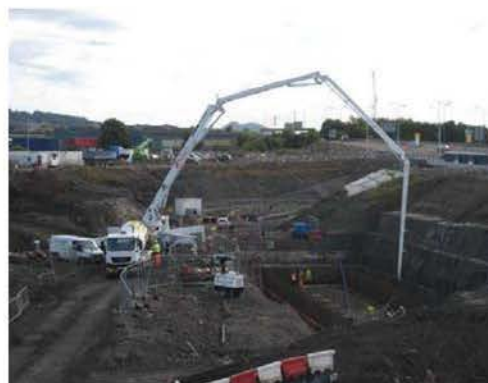
Concrete Pour at Attenuation Tank
